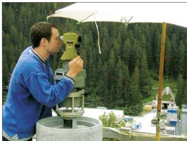
Маркшейдер производит ориентирование тоннеля в Альпах с помощью GYROMAT-2000. 90-е годы
